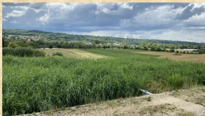
Un des trois bassins de la station d'épuration d'Autreville
