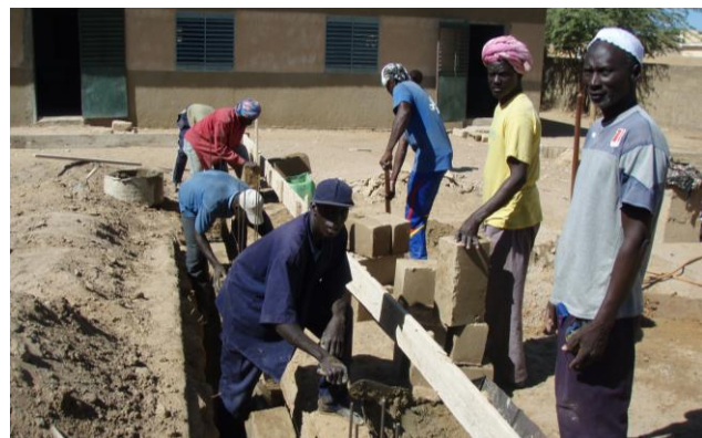
Construction de la bibliothèque de Bokhol
