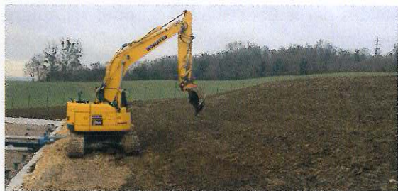
Façonnage du talus qui sépare les bassins
