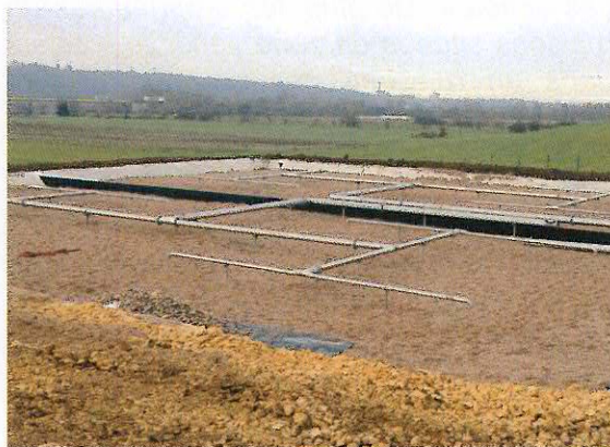
Les rampes qui amènent les eaux usées sont posées
