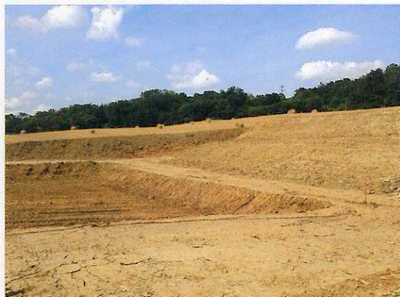
Terrassement des bassins
