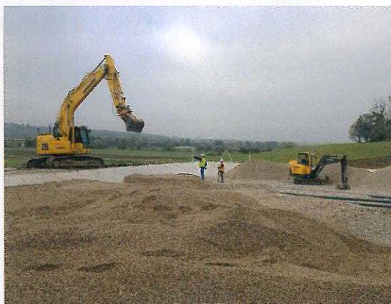
Garnissage des bassins avec les matériaux filtrants
