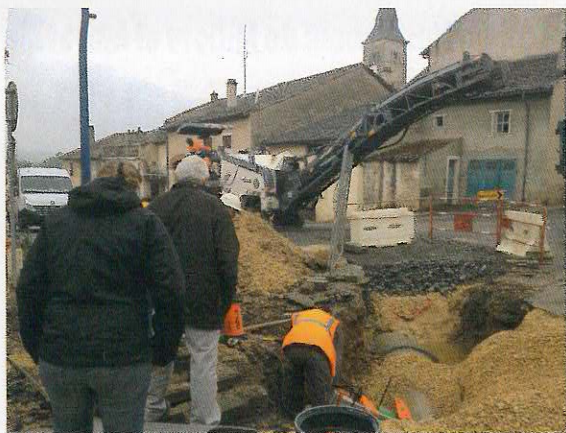
Travaux Grande Rue et rue des Roses à Millery
