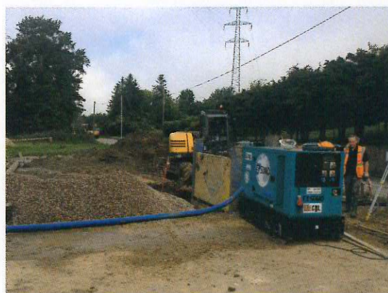
Pose de la pompe de relevement à Autreville
