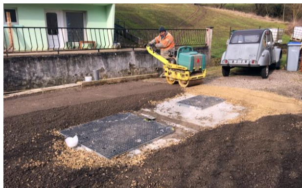
Travaux en cours rue du Moulin à Millery
