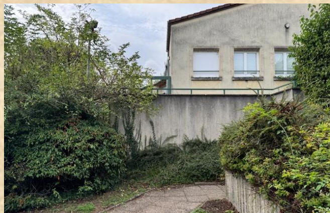
Un nouvel escalier desservira la cour de l'école et la salle
