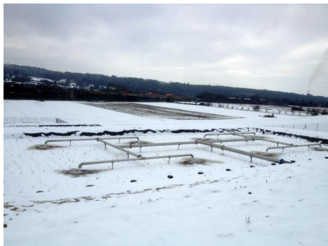
Mise en service de la station d'épuration sous la neige
